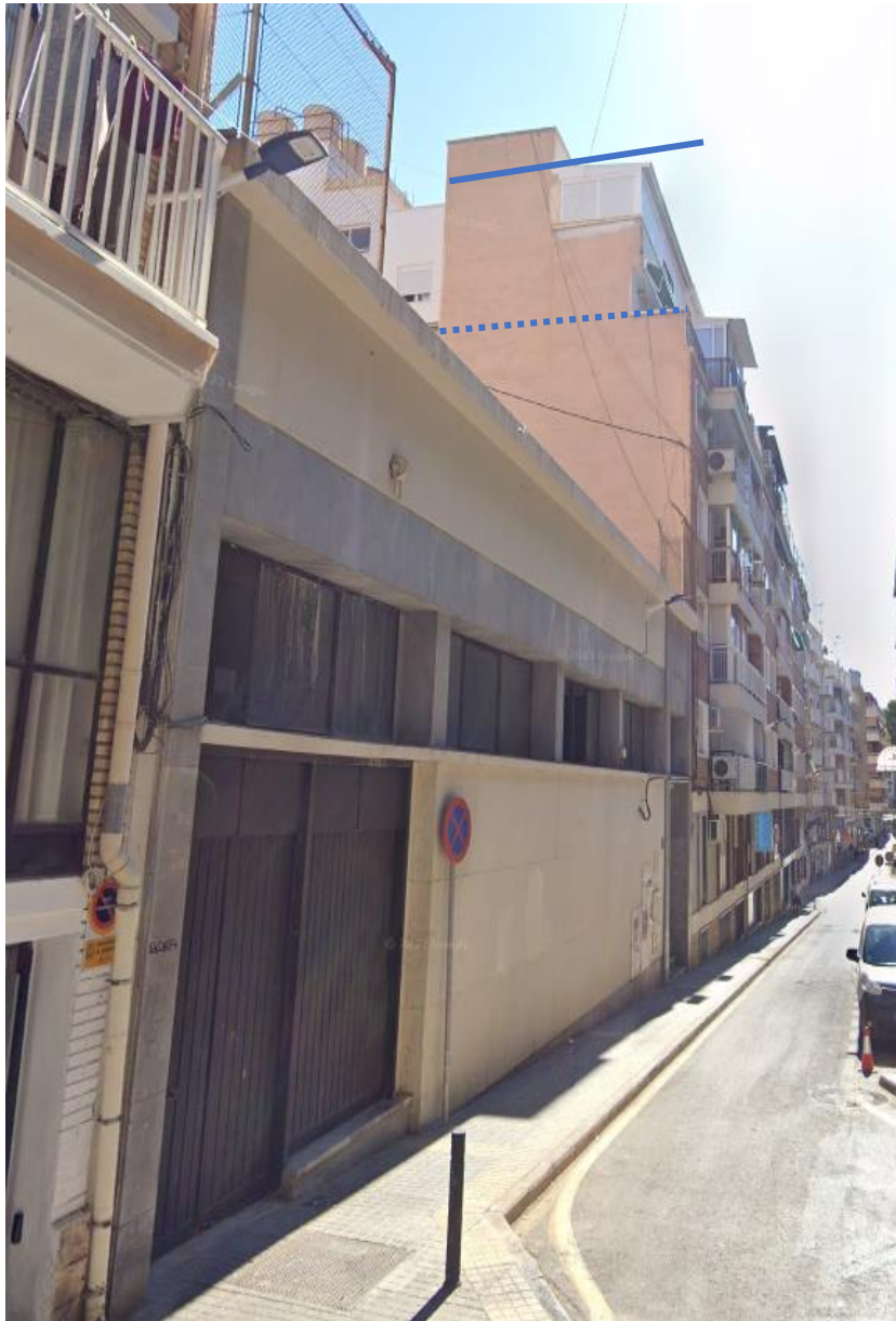
Vista medianera derecha con Calle Mercado 14.
