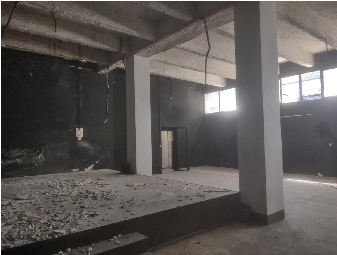
Vista del interior del edificio existente.
